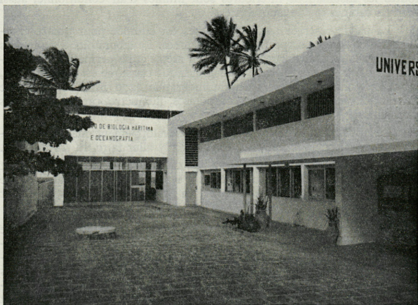
Fig. 1. — La cour intérieure de la station.
